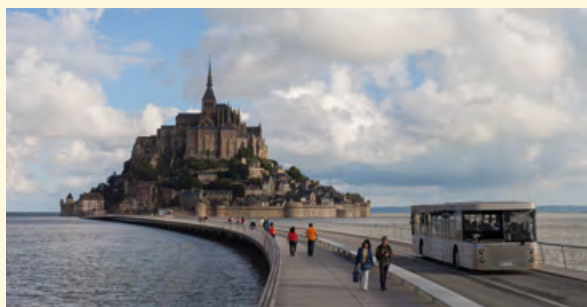
Die Brückenüberführung, die neue Verbindung zum Mont-Saint-Michel
